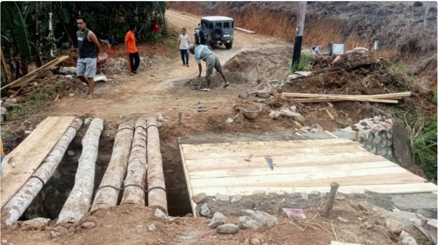
Pasaman, - Satgas TMMMD ke-119 Kodim 0305/Pasaman membangun jembatan darurat untuk memperlancar pengecoran lantai plat daiker dan pembangunan badan jalan, Senin (18/03/2024).
